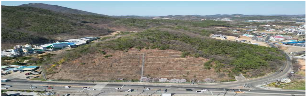
절토사면(김포 월곶 군하 I) 전경
